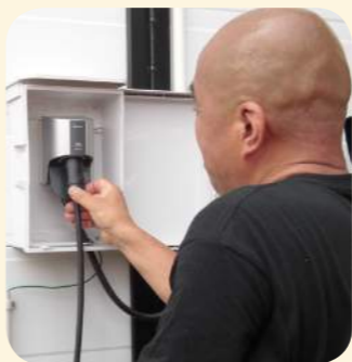
仮設団地に設置したEVの充電設備
